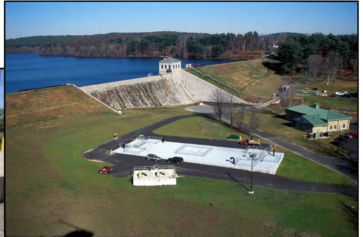
MWWST Shaft E
